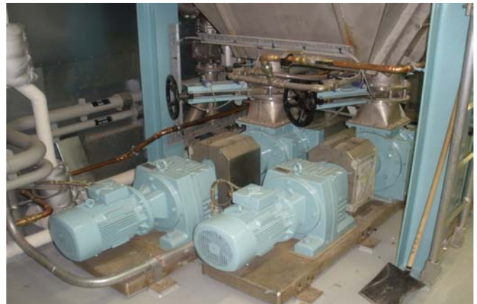
2 Stk. Pumpe ES-HA für Weitertransport von Speiseresteabfällen aus Speiserestetank
