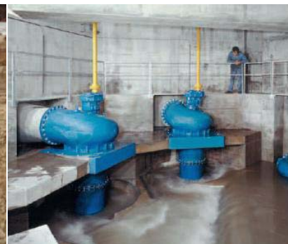
Abwasserhebeanlage mit vertikaler Montage
