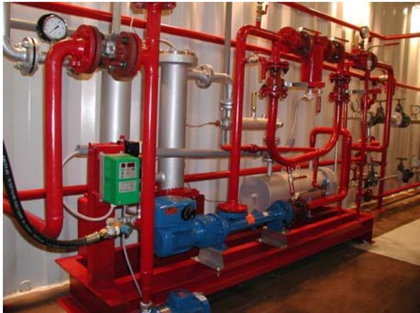
Gleichzeitig wurde in einem weiteren 20'Container eine Membrananlage installiert, welche die abgetrennte noch mit Öl behaftete Wasserphase wieder so aufbereitet, dass das gereinigte Wasser dem öffentlichen Abwassernetz zugeführt
