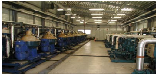
Blick in die Separatorenhalle
