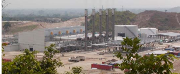
Blick auf die Power Plant in Choloma / Honduras während des ersten Bauabschnitts mit 5 Motoren für 80 MW Leistung
