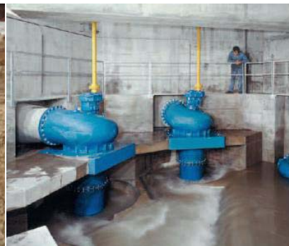
Abwasserhebeanlage mit vertikaler Montage
