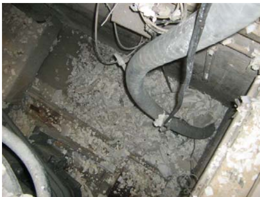
Sumpf, gefüllt mit Papier/Wasser-Gemisch, während des Abpumpens mit der Zerhackerpumpe
