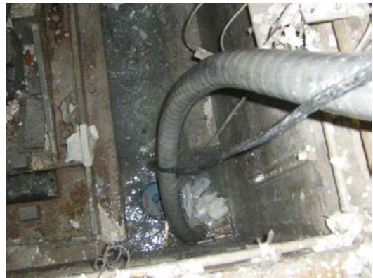
Zerhackerpumpe, im Sumpf eingesetzt, während der Arbeit
